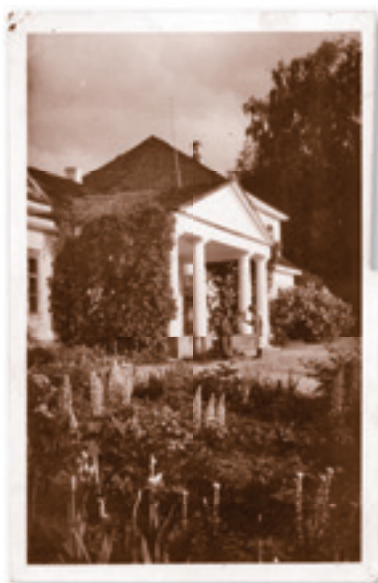
❖ Dwór w Zosinie po przebudowie w 1937 r.
