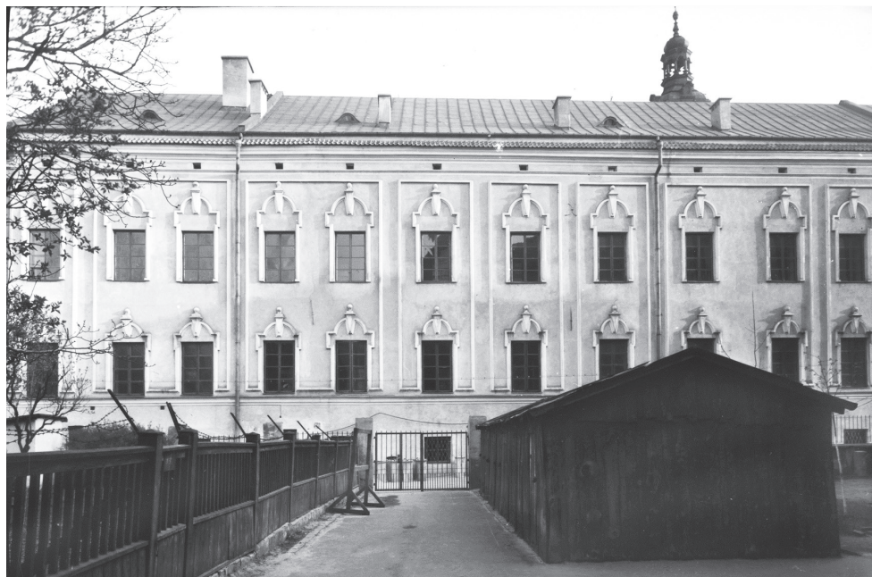
6. Budynek Archiwum po oddaniu do użytku, lata 60. XX w. Widok od ul. Jezuickiej
